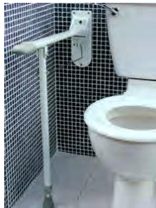
Barre d'appui murale munie d'une béquille de renfort.
