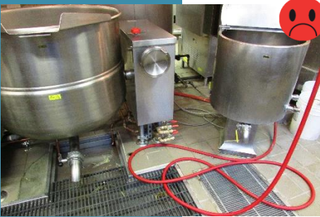
2.9.2 Tuyau déroulé dans un passage
