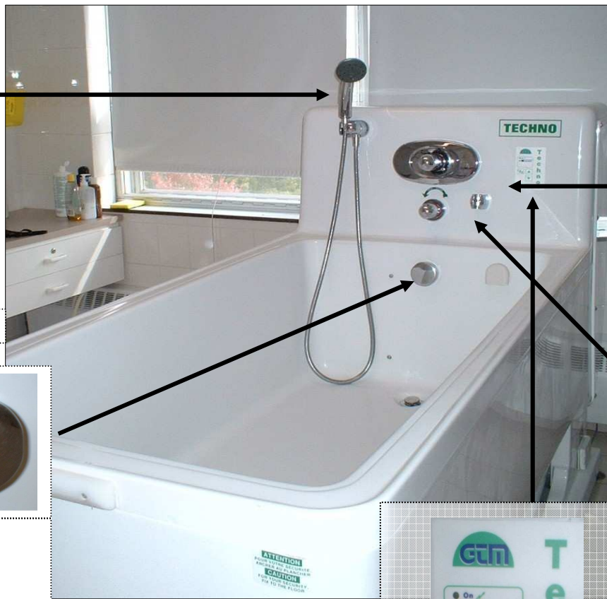
Mécanisme de renvoie avec système anti-débordement.
