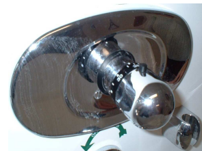
Sélecteur de température : avec blocage de sécurité à 38° C.
